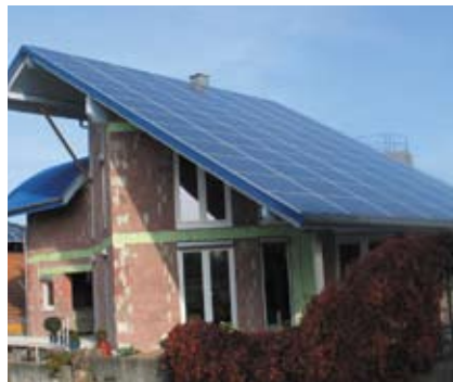
17kW-Anlage, Aufdachanlage (Deutschland)
