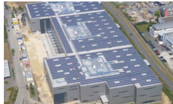
1MW-Anlage, Aufdachanlage, Holy-AG (Deutschland)
